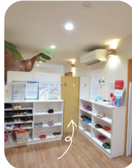
パネルとドアを靴箱に取り付けて新たな壁を製作
