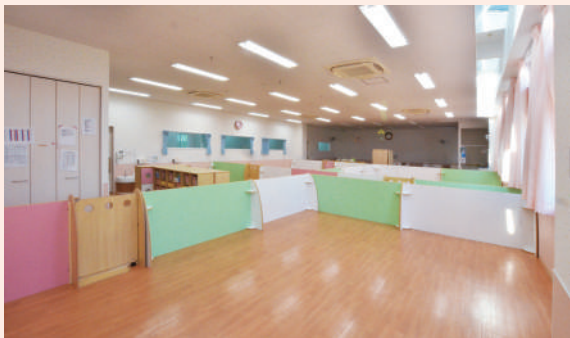
最長幅9.7mのパーティション。床暖房のため床固定せず、コ型やH型などの形に連結する事で転倒を防止します。 にじの森保育園(東京都荒川区)
