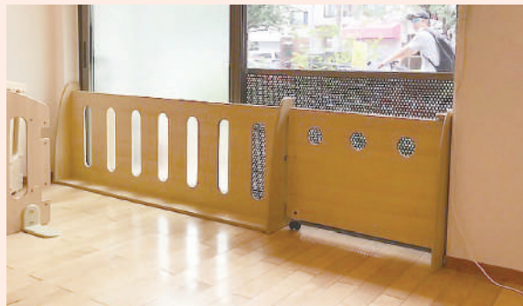
壁や床に固定できると、窓際のパーティションも窓ギリギリに、且つ強固に設置できます。 駒沢ほしにねがい保育園(東京都世田谷区)
